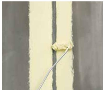
3. Po vytvrdení vyrovnávacej malty, plochu znova celú napenetrujeme a na spoje stien nanesieme hydroizolačnú fóliu Murexin Tekutá fólia **1KS**. (Tekutá fólia **1KS** - Rapid)
