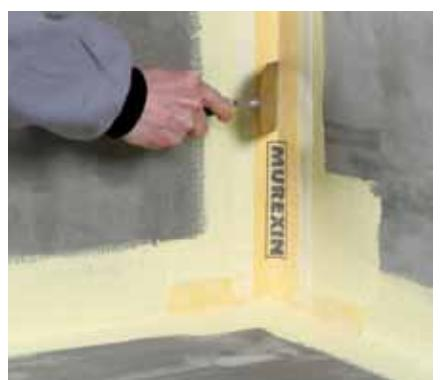
6. Následne vtláčime pomocou špachtle tesniaci pás Murexin Izolačná páska **DB 70** aj na spojoch stena a stena. Spoje tesniaceho pásu by mali byť prekryté minimálne 5 cm.
