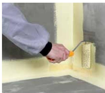
5. Na okraje dôkladne nanesieme do stačného vrstvu hydroizolačnej fólie.
