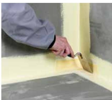
4. Do čerstvej hydroizolačnej hmoty v rohovom spoji podlahy a stena vtláčime pomocou špachtle systémový komponent Murexin vnútorný alebo vonkajší roh.
