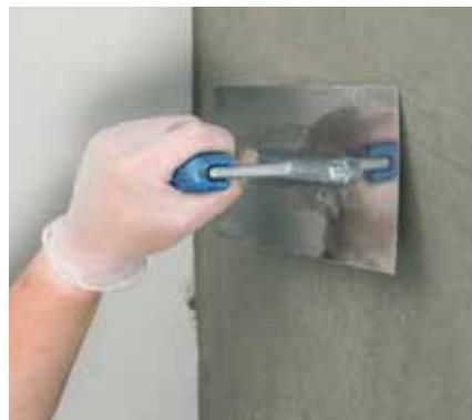
2. Ak sú na ploche veľké nerovnosťi povrchu, tak ich opravíme Murexin Vyrovnávacou maltou **AM 20**.
