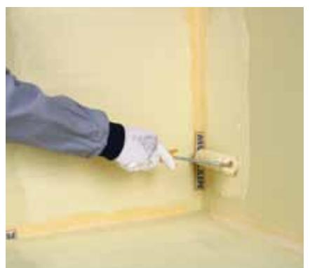
9. Po celej ploche rovnomerne nanesieme hydroizolačnú fóliu tak, aby boli dôkladne prekryté textilné okraje tesniaceho pásu. Tesniaci pás nepretierame celý. Po zaschnutí prvého náteru celú plochu pretrieme ešte raz.
