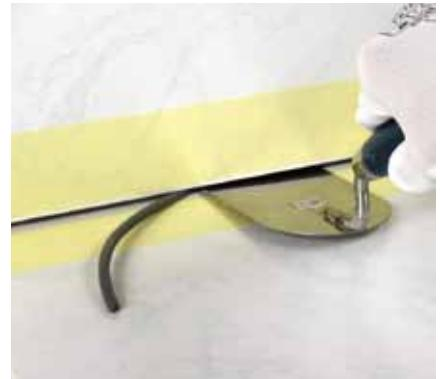
15. Spojé stena-stena a stena-podlaha oblepíme maskovaciou páskou a natlačíme do nich Murexin škárovací povrazec.
