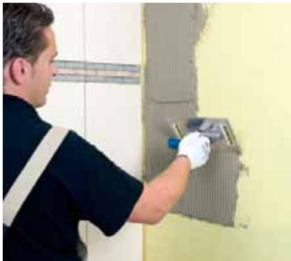
10. Na zaschnutú hydroizoláciu nanesieme zubovým hladidlom Murexin Pružnú lepiaci šedú **KGF 65**.
